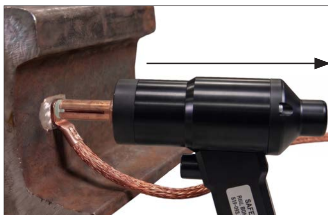
6. Po dokončení pájení počkejte 3 sekundy a vytáhněte pistoli přímo dozadu, aniž byste stiskli spoušť.
